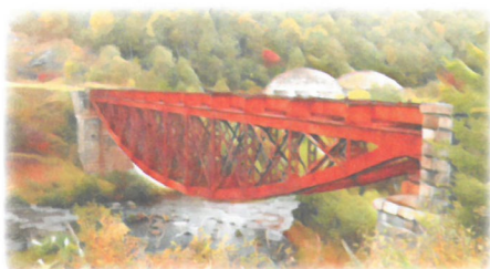
Шабартуйский комплекс — железный мост и железобетон- ный двухпролётный виадук
